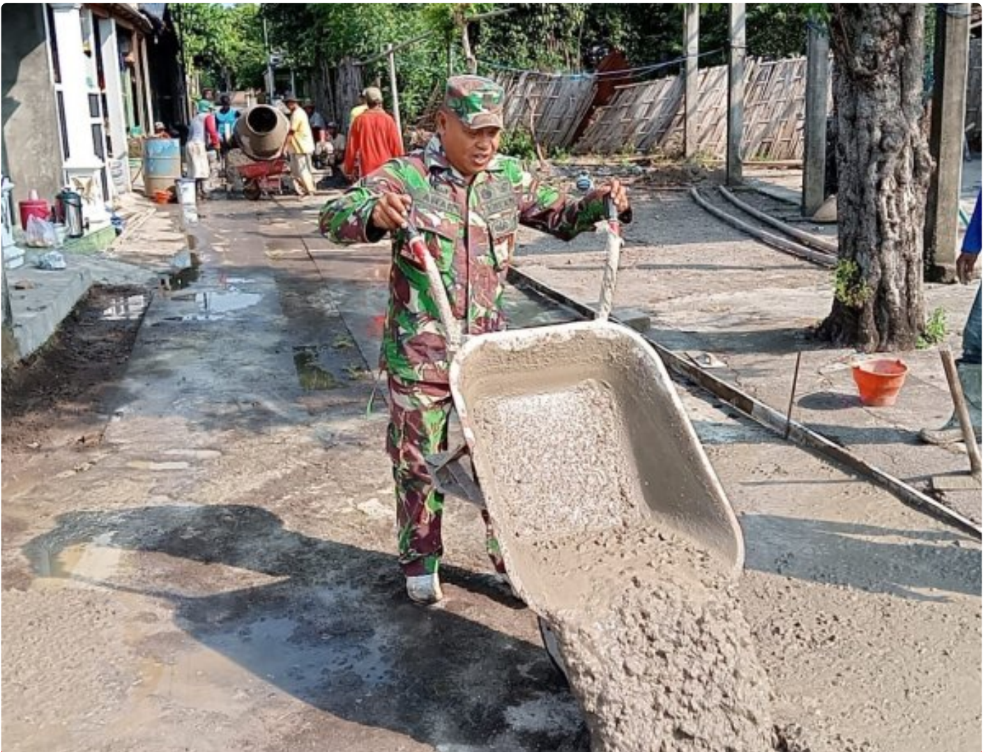
Babinsa Desa Wadunggetas Bersama Warga Gotong Royong Dalam Karya Bakti Betonisasi Jalan
